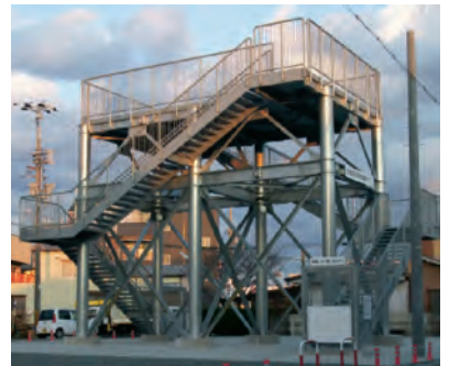
つなみひなん 津波避難タワー わかやまけんたなべし (和歌山県田辺市)
