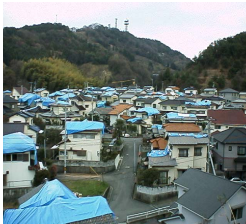
祝谷の住宅の被害状況(愛媛大学 森助教授撮影)。青いシートがかかっています。
