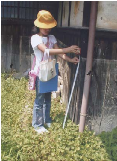
土石流の痕跡を調べている
