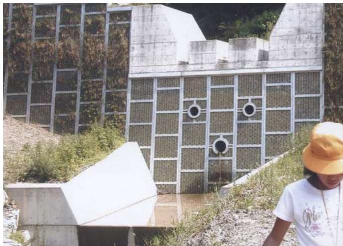
砂防ダムの調査
