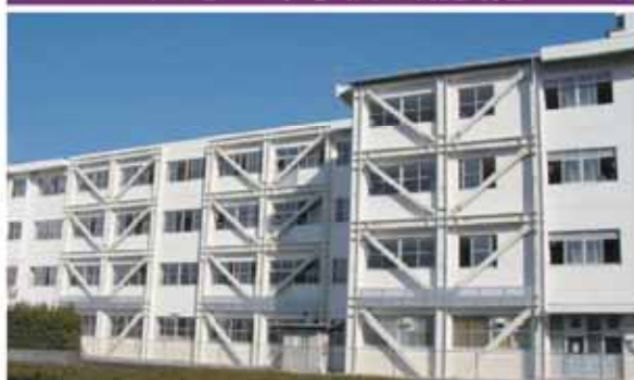
膝機中学校校舎（静岡市）
