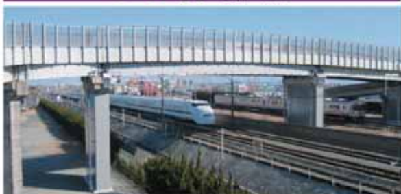
（他）新居12号線・新居跨線橋（新居町）
