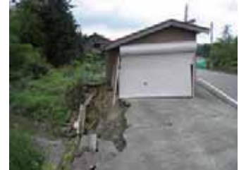
河川沿いの地盤変状
