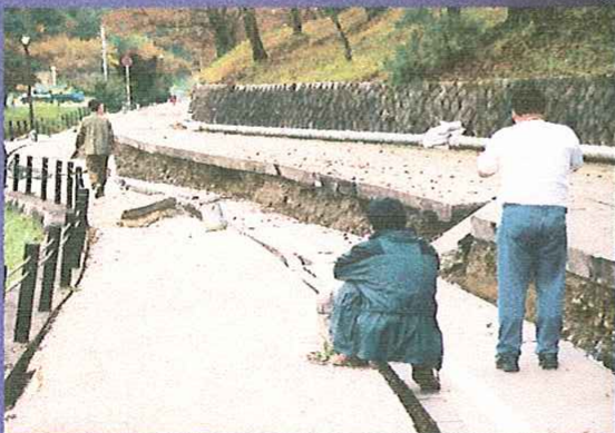
アスファルト道路の損壊
