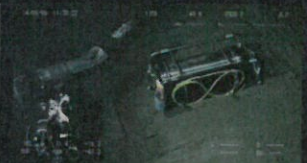
外部バッテリー設置
