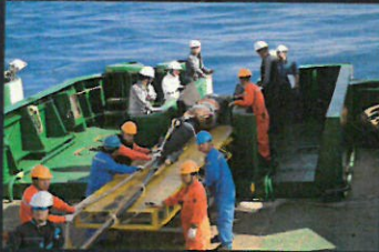
分岐装置 (BU) 敷設
