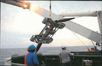
終端装置 (TU) 敷設
