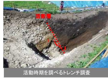
活動時期を調べるトレンチ調査
