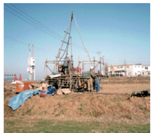
深谷断層帯のボーリング調査 （群馬県藤岡市） 写真提供：群馬県
