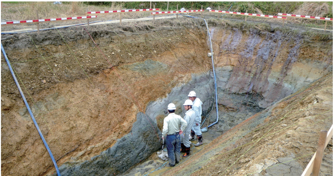
図 2 小倉東断層におけるトレンチ調査（北九州市小倉南区）
