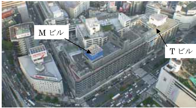
写真3 解体前の建物の配置
