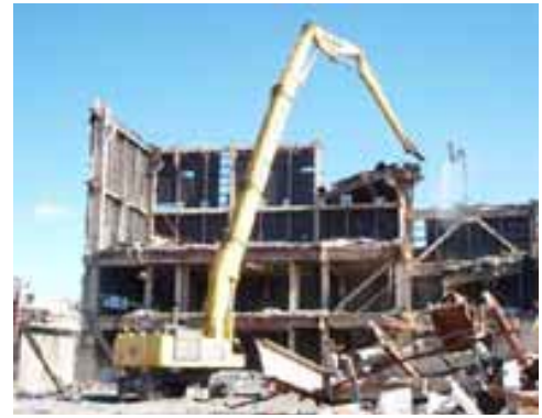
写真4 超ロングバックホーによる解体
