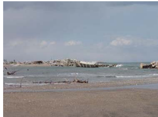
(b) 崩壊した海岸構造物（山元町）
