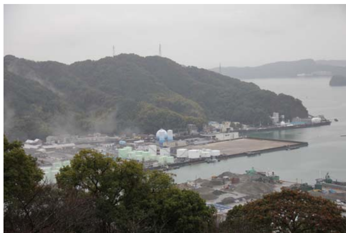
写真8 浦戸湾内における石油タンク
