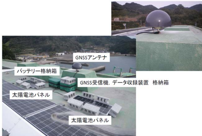
図2．新設した GNSS 観測点の写真。右上は GNSS アンテナの設置状況、左下は全体の設置状況を示す。
