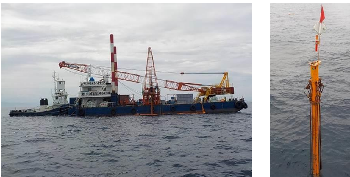
図 48 傾動自在型工法の作業状況 (左：全体の状況写真、右：台船を離した状態写真)。
