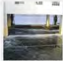
浸水状況(魚市場)
