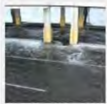
浸水状況(魚市場)
