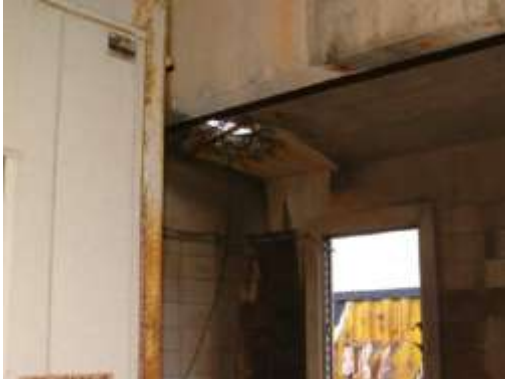
写真 建物を貫通した噴石のあと
