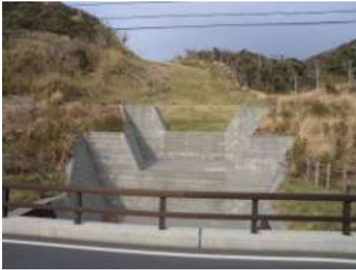
写真 砂防ダム
