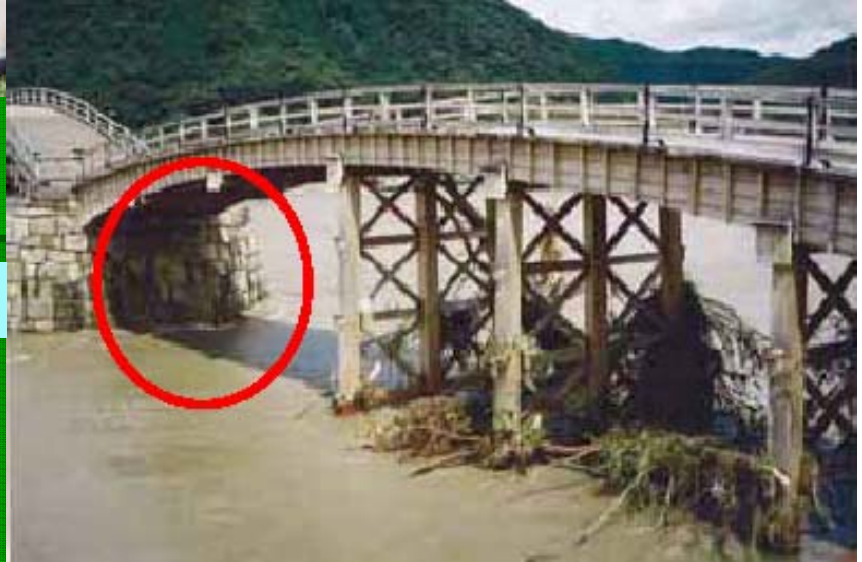
錦帯橋の被害状況
