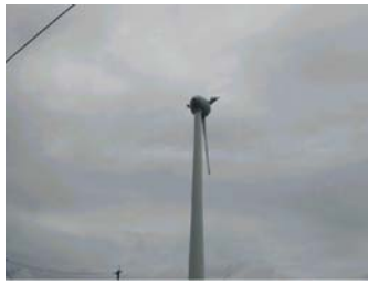
1号機:三菱重工業(250kw) プロペラー部破損
