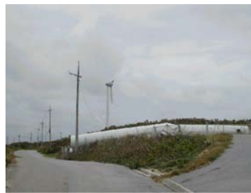
3号機:ミーコン デンマーク製(400kw)、倒壊
