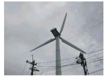
4号機:ミーコン デンマーク製(400kw) 被害なし
