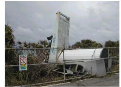
5号機:ミーコン デンマーク製(400kw) 倒壊
