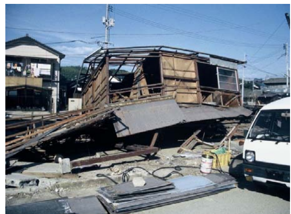
浸水後の家の中(上) 高潮で壊れた家(下)
